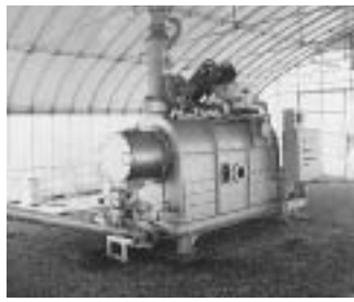
写真1 木質熱変換装置(炭化炉)
